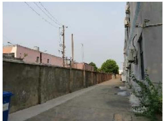
图 8-2 辐射调试间东侧
