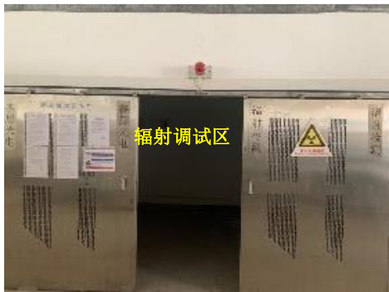
图 8-1 辐射调试间现状
