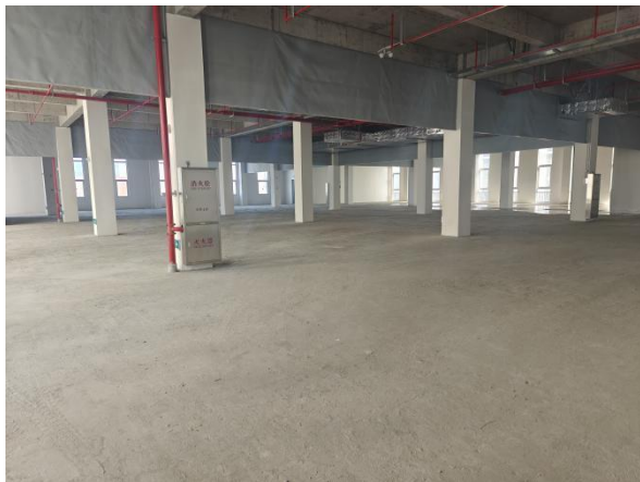
图 8-3 本项目实验室拟建址上方（7 号楼三层）
