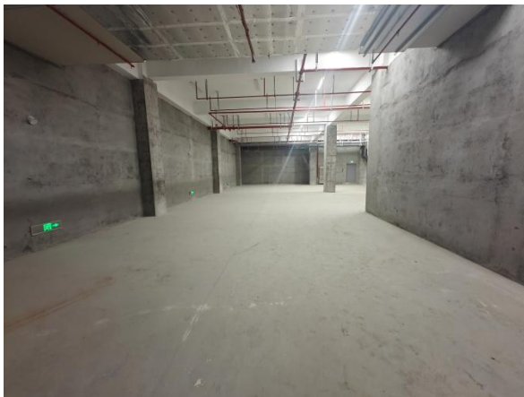
图 8-2 本项目衰变池拟建址（7 号楼地下室）
