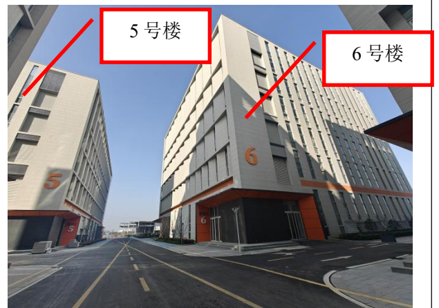
图 8-7 本项目拟建址西侧及西南侧
