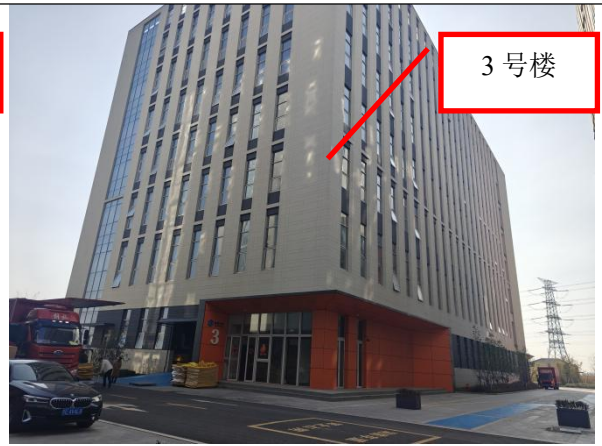
图 8-5 本项目实验室拟建址东南侧
