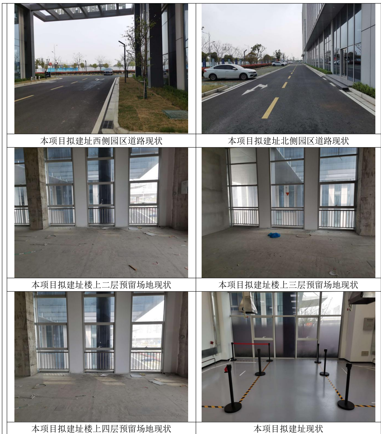
图 8-1 本项目工业 CT 装置拟建址周围环境现状
