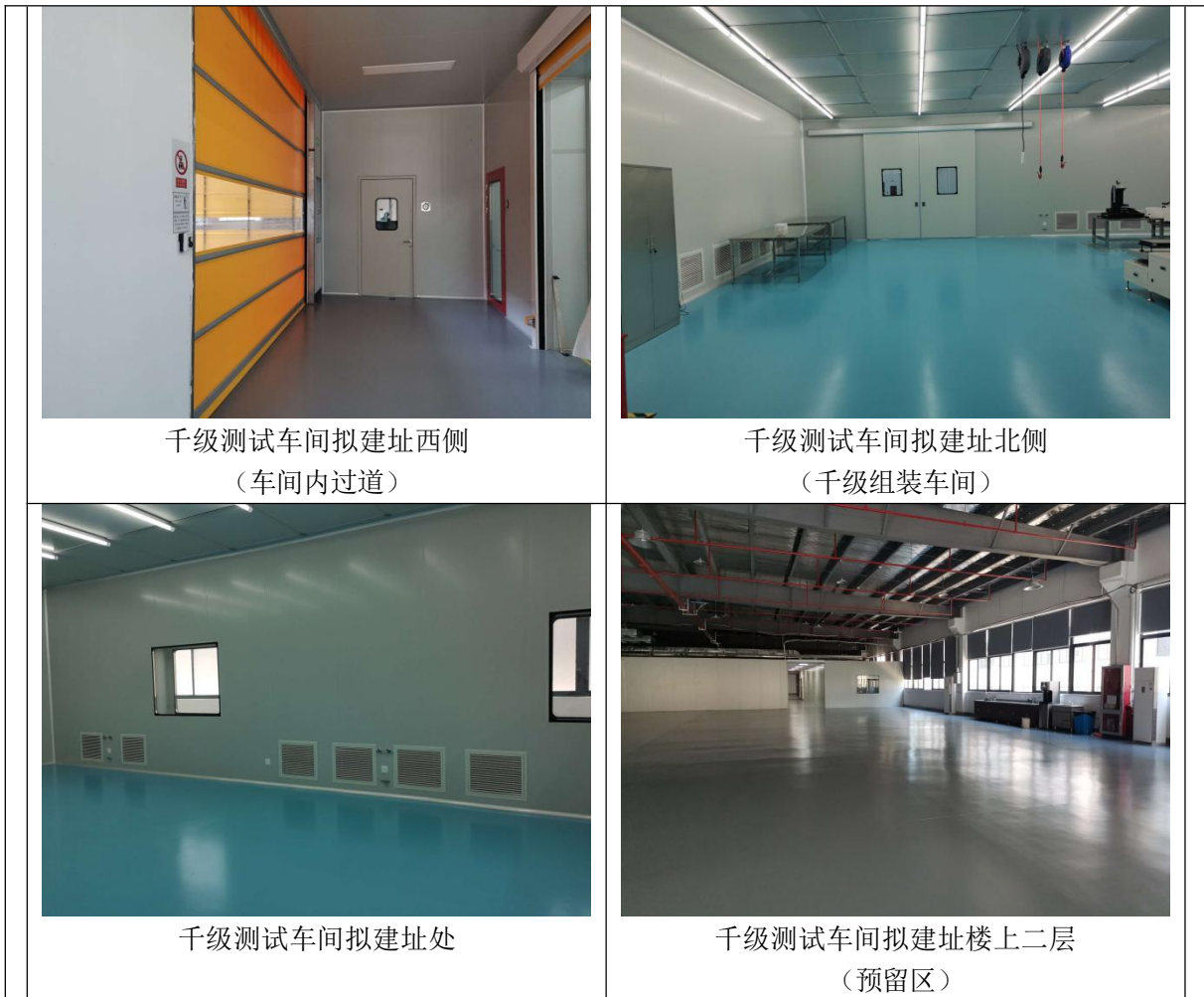
图 8-1 本项目千级测试车间拟建址周围环境现状照片
